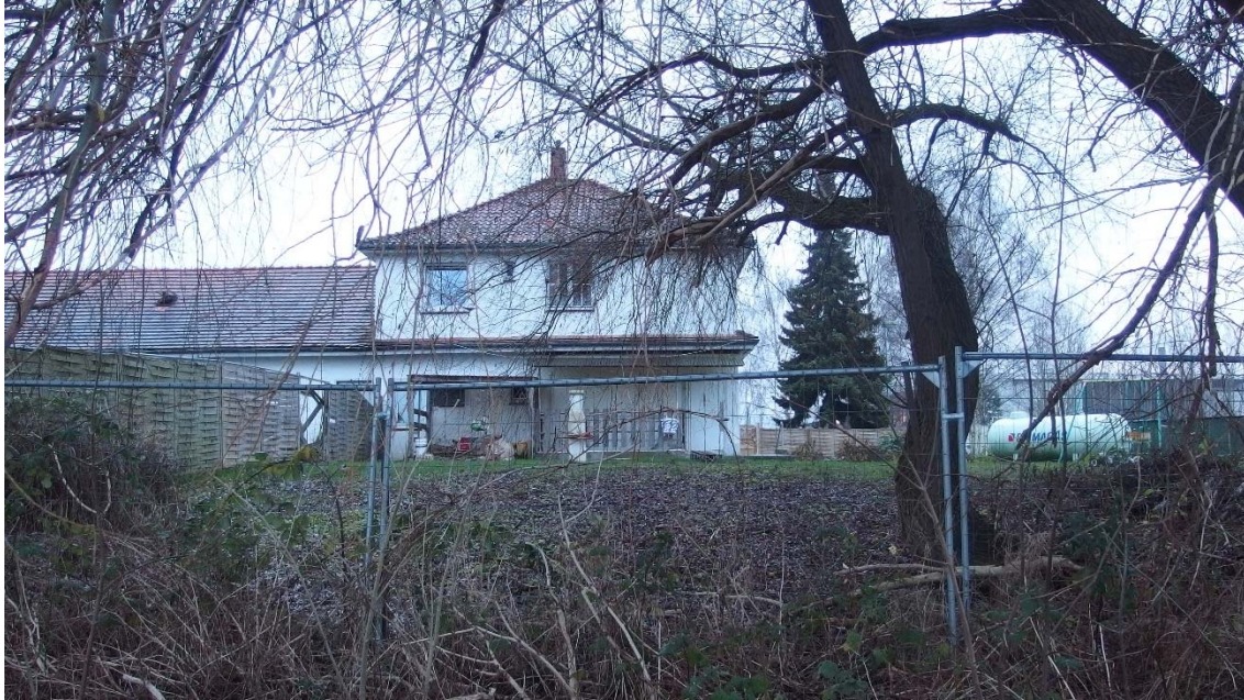
Abb. 3: Blick nach Südosten auf die nordwestliche Gebäudeseite. Im linken Bildrand befindet sich ein Zaun als Sichtschutz. Dahinter stehen Kraftfahrzeuge (siehe Abb. 4).
