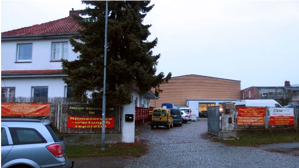
Abb. 5: Blick nach Nordosten von der Straße „Bei der Gasanstalt“ auf die südöstliche Grundstücksfläche. Im linken Bildrand befindet sich das Gebäude (Abb. 1-3). Die Auffahrt des Grundstückes ist mit Kopfsteinpflaster versiegelt.
